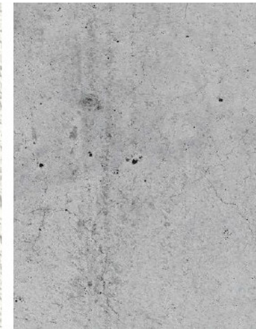
5 Betonwände und -decke
